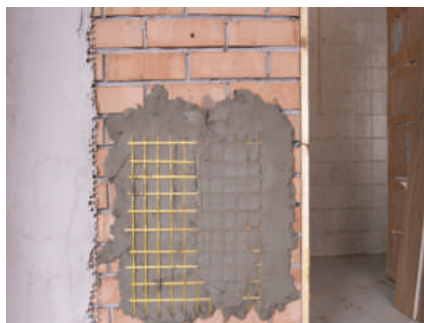
4. APLICAREA BUCĂȚILOR DE 160 x 160 PLASĂ HERCUNET
