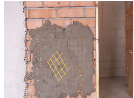
3. APLICAREA PLASEI STRUCTURALE HERCUNET
