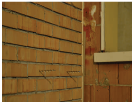
1. GAURIREA ȘI INTRODUCEREA BARELOR DE OȚEL HELIKON
