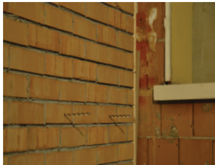
1. GAURIREA ȘI INTRODUCEREA BARELOR DE OȚEL HELIKON
