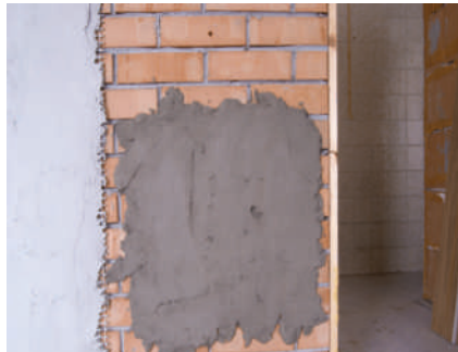
2. PRIMA MANĂ DE MORTAR STRUCTURAL BIO FORCE ONE
